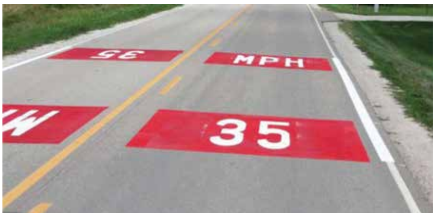
รูปที่ 8 การทำถนนที่มีสีแดง บนตัวหนังสือบอกความเร็วที่กำหนด
