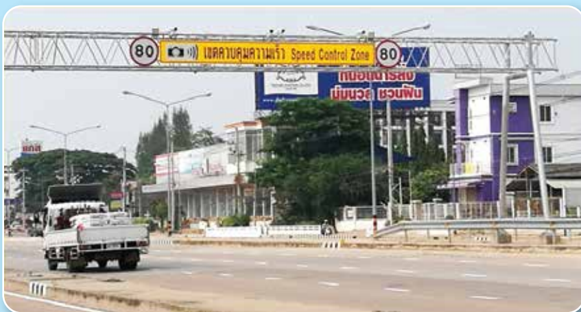
รูปที่ 4 กล้องตรวจจับความเร็วติดตั้งบนโครงเหล็ก (ตำแหน่ง SE02)
