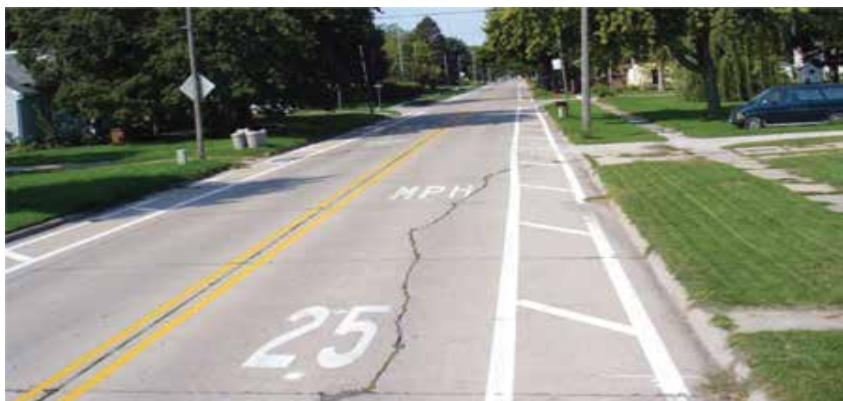
รูปที่ 7 การตีเส้นไหล่ทาง (Shoulder Markings) เพื่อลดความกว้างของช่องจราจร
