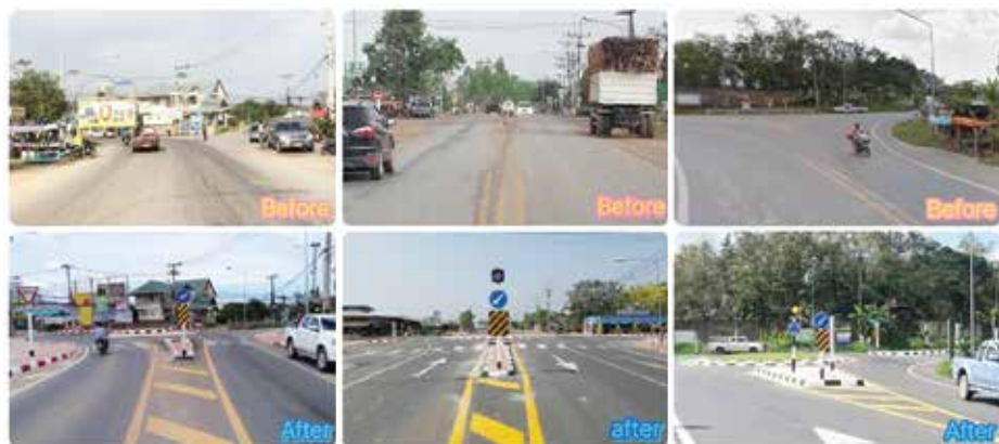
รูปที่ 10 เปรียบเทียบทางแยกก่อนและหลังการปรับเปลี่ยนสภาพเป็นวงเวียน
