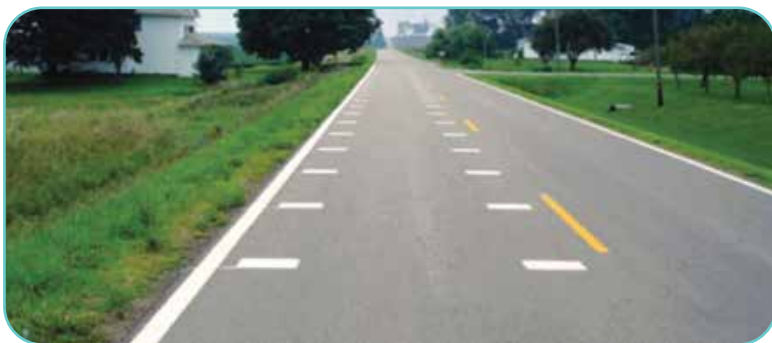
รูปที่ 4 การตีเส้นประขวางแนวจราจร (Transverse Markings)
