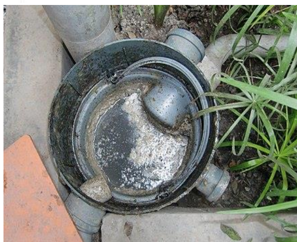
รูปที่ ๒ บ่อดักไขมันแบบวงขอบซีเมนต์ - ทรงกลม
