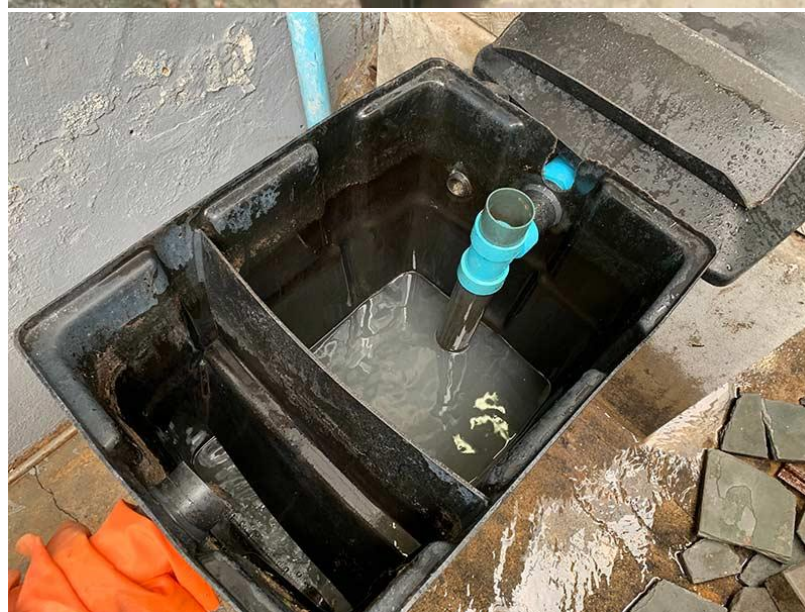
รูปที่ ๑ รูปแบบทั่วไปของบ่อดักไขมันสำเร็จรูป
