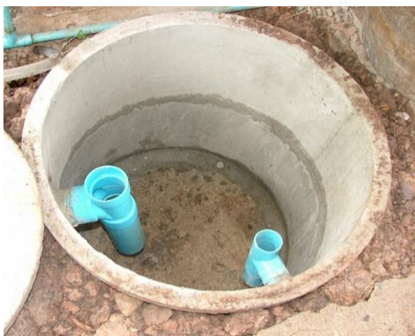
รูปที่ ๒ บ่อดักไขมันแบบวงขอบซีเมนต์ - ทรงกลม
